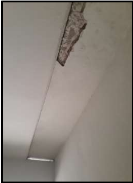
Teto com infiltração
