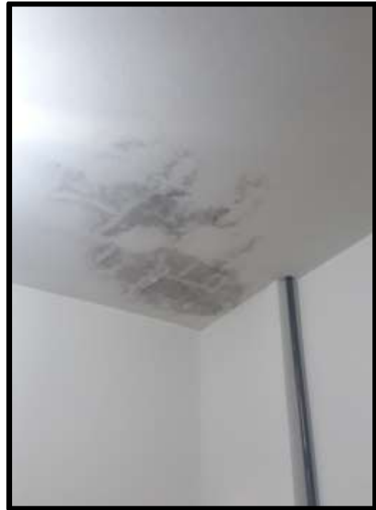
Teto com infiltração
