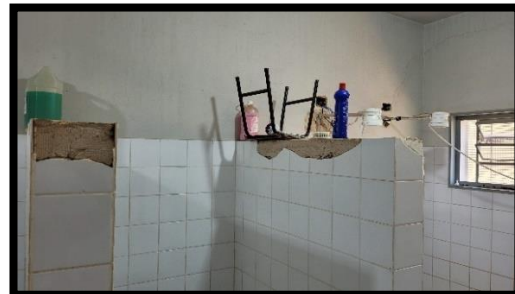
CEMEI Ena Peixoto Junqueira – Banheiro com azulejos quebrados e parede com rachaduras.
