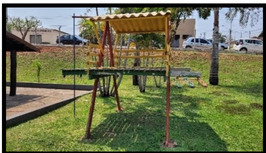
CEMEI Áurea Neves Rodrigues – Playground danificado e inutilizado.
