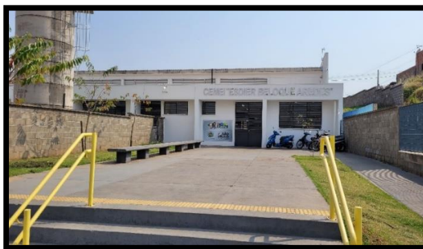
CEMEI Esdier Beloque Aredes – Visita em 13/09/2022.
