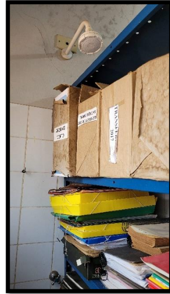
CEMEI Ena Peixoto Junqueira – Banheiro improvisado como arquivo morto.
